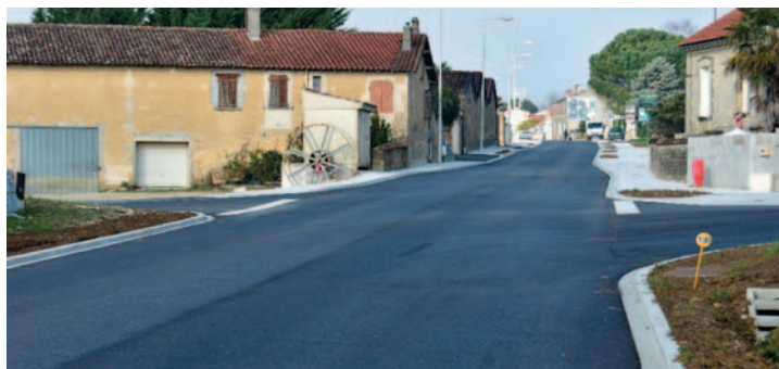
Av. Malakoff après travaux
