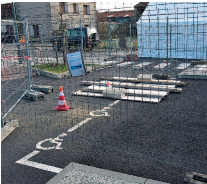
L'entrée de l'effondrement sous la plaque de protection
