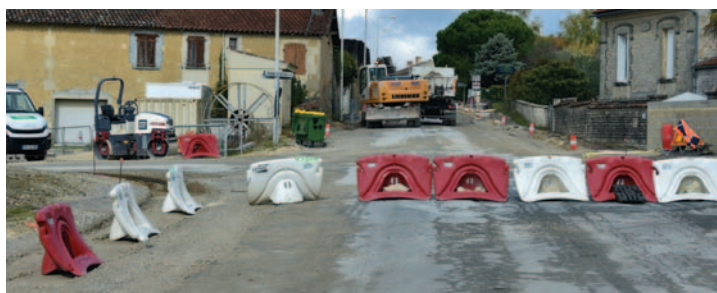
Av. Malakoff au démarrage du chantier
