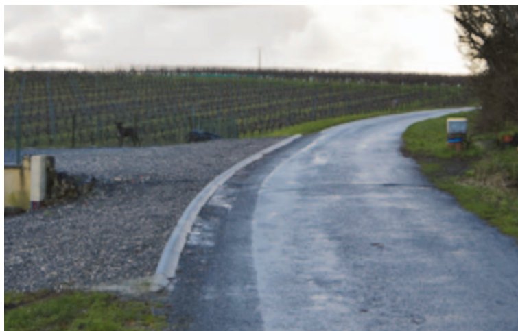
Pose de bordures et raccord chaussée chez Berlouin.
