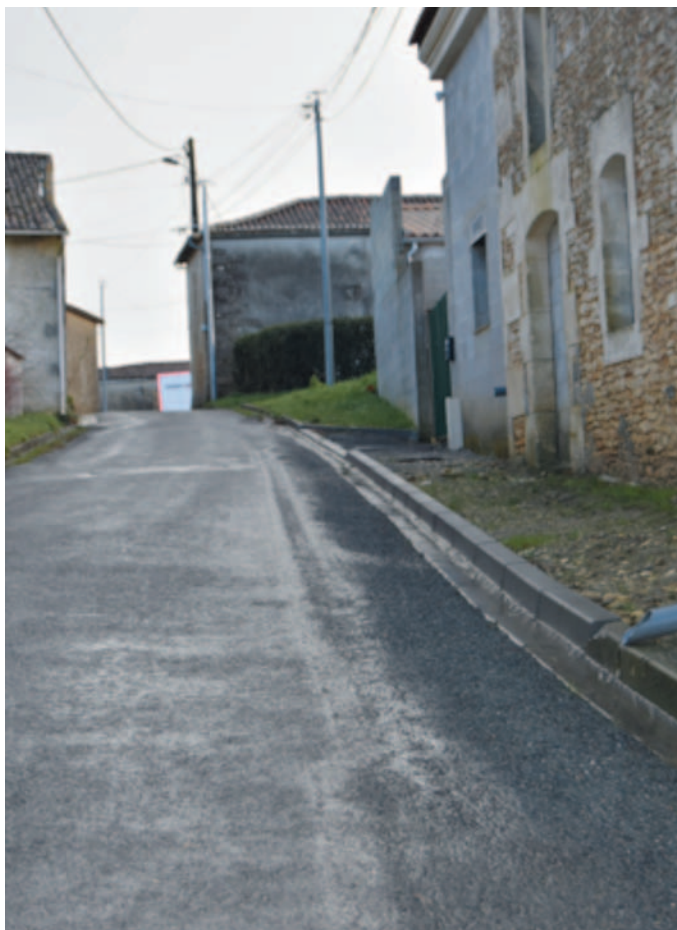
Pose de bordures et raccord chaussée au Chêne.
