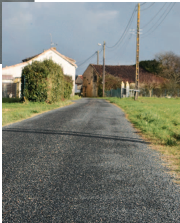
Réfection de 640 m de chaussée de Chez Bluteau à Chez Guillon.
