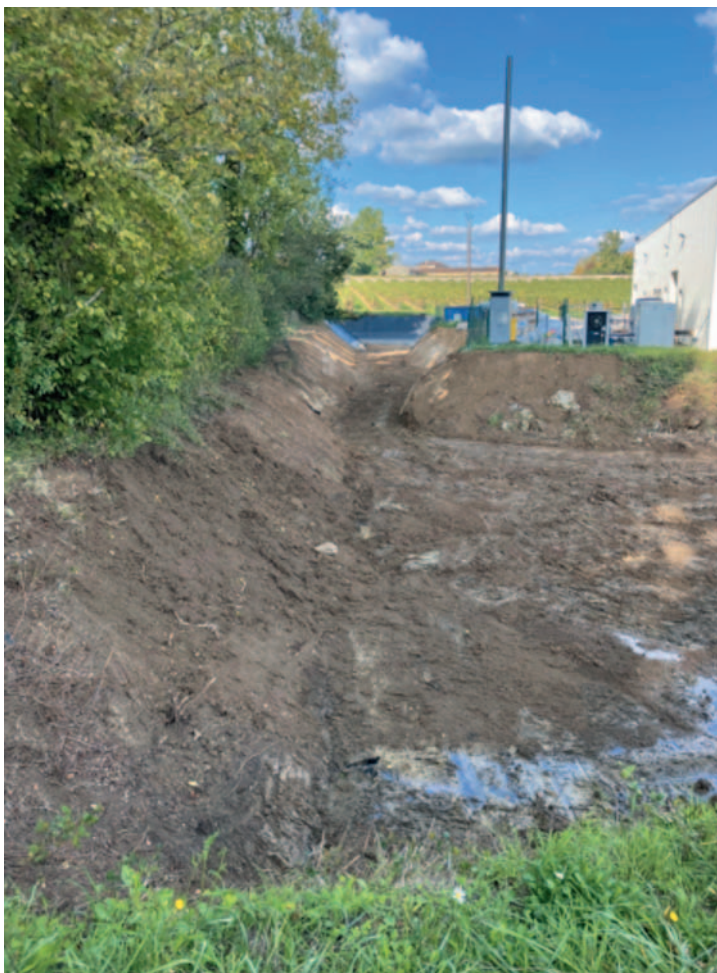
Curage du bassin d'orage de Carrefour.
